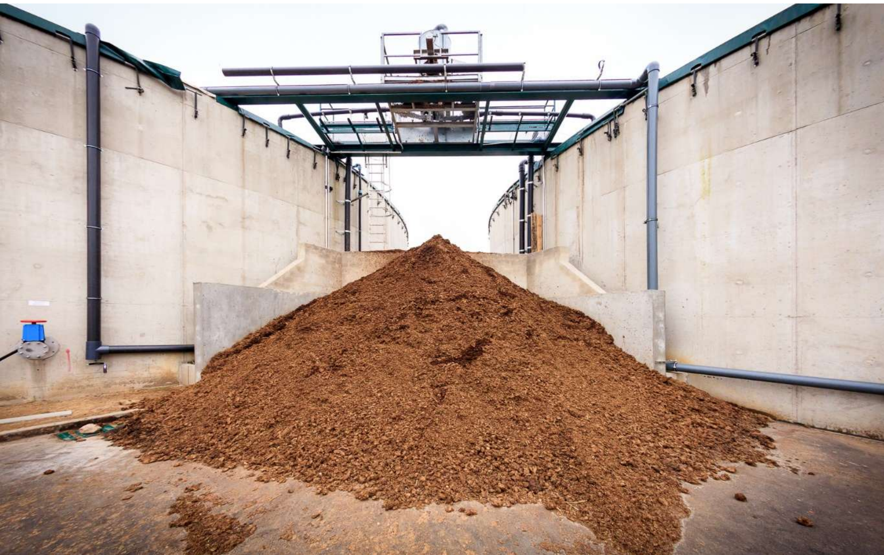
Separator pofermentu pomiędzy zbiornikami końcowymi na poferment
